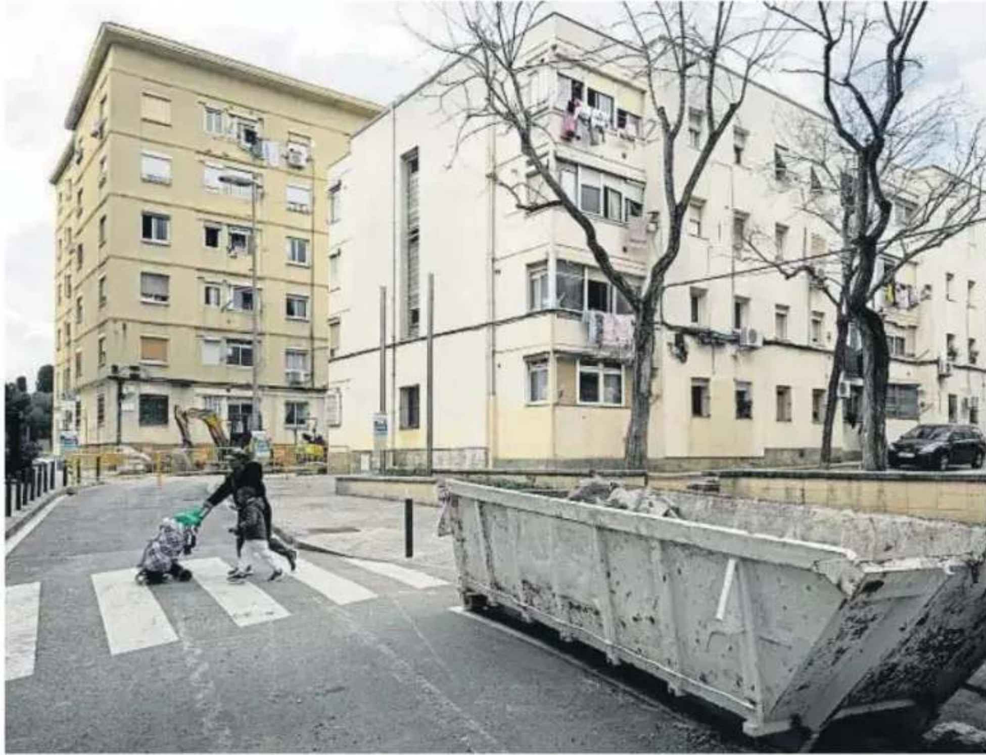
La rehabilitación de viviendas y la mejora de la eficiencia energética forman parte del proyecto
